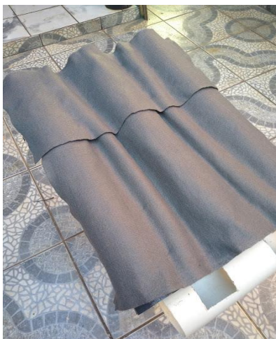
Figura 6 – Implantação do Bidim
